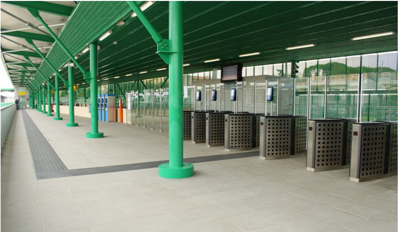
Fig.2 - I varchi di accesso sul binario in stazione
