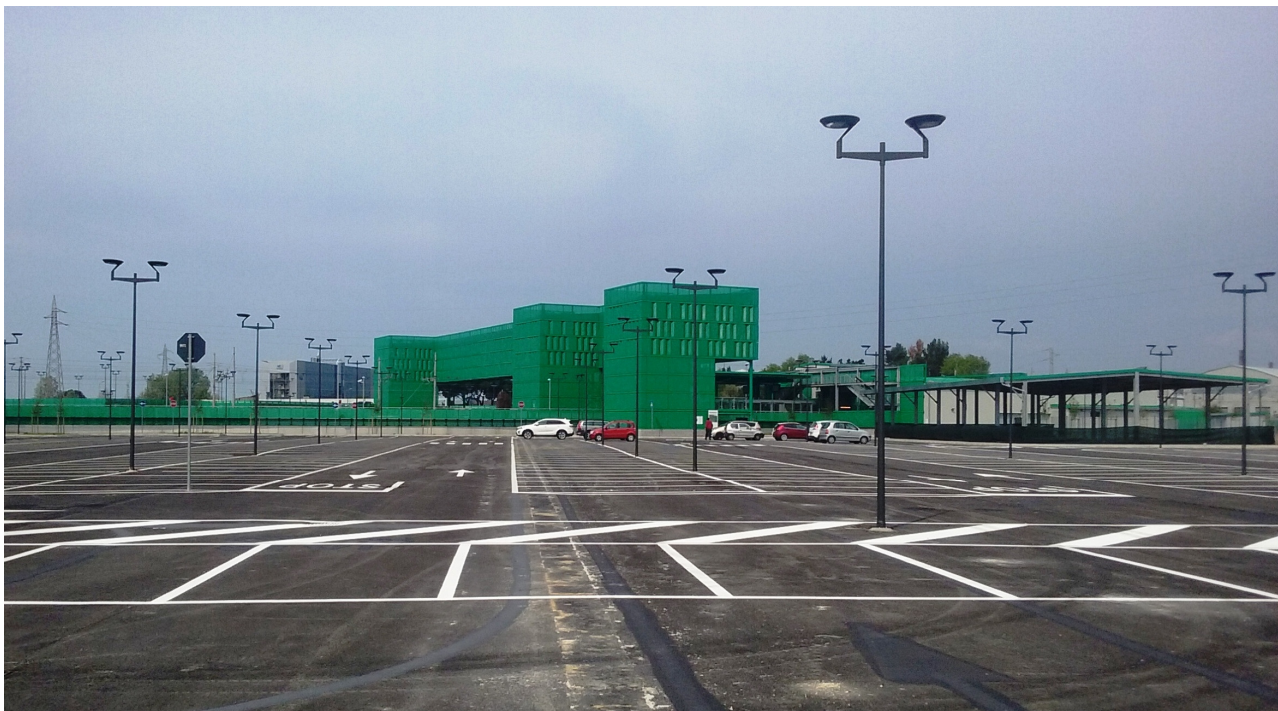
Fig.5 - Il parcheggio di via di Goletta con la struttura di sovrappasso della ferrovia.
